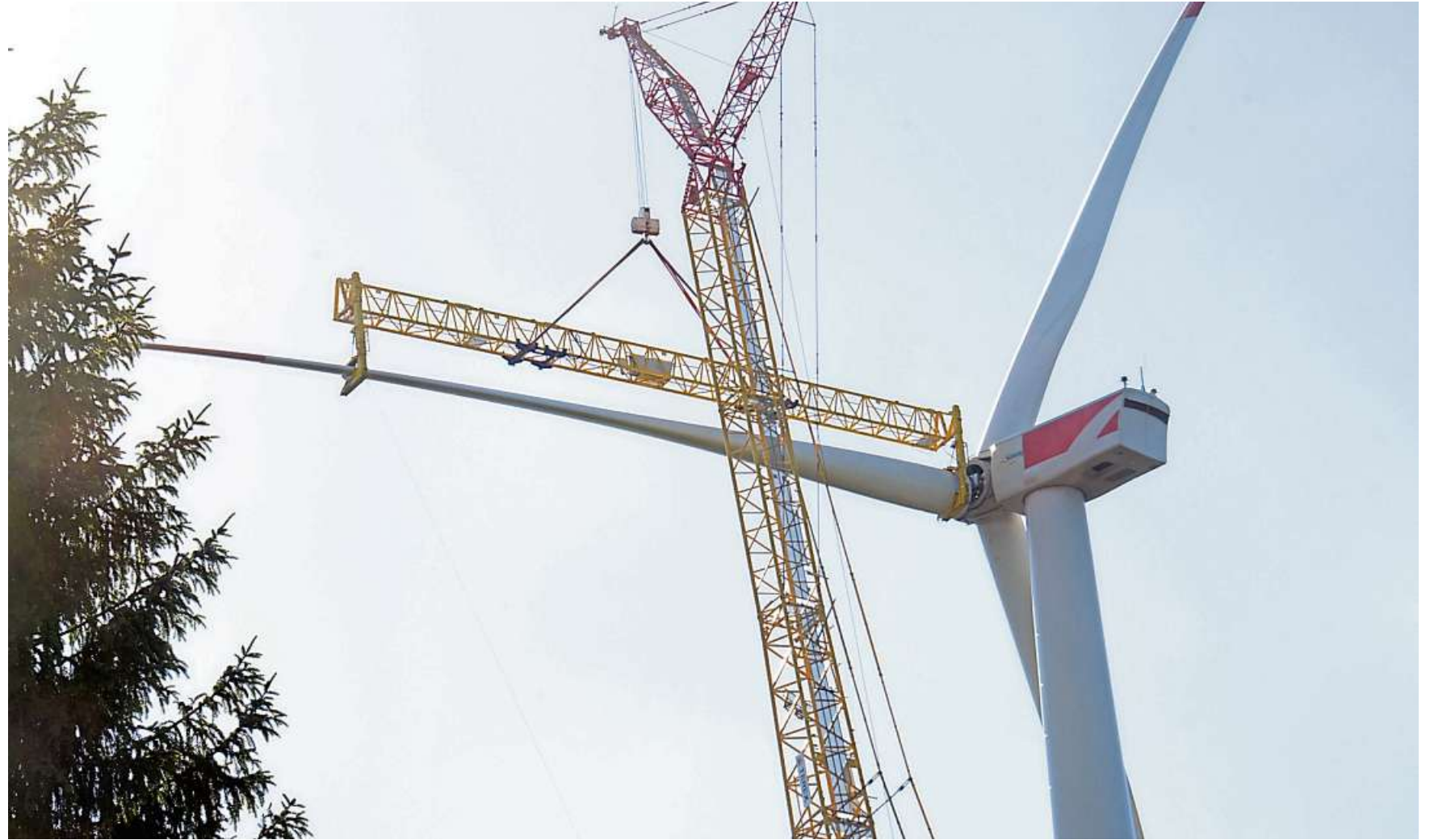
Monatelang gehörte ein kolossaler Kran zum Landschaftsbild im Heidenroder Windpark. Wind war die Ursache für mehrere Verzögerungen.
