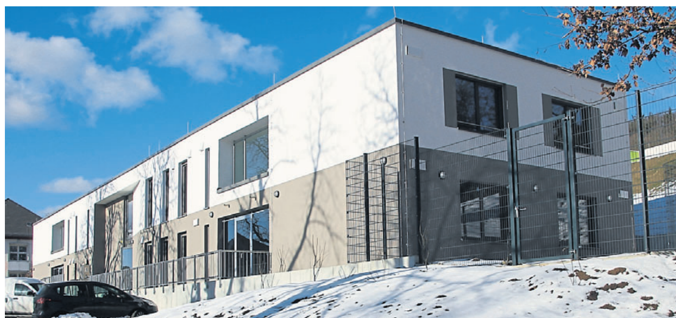
Unterhalb der Klinik Rheinhöhe ist ein zweigeschossiges Gebäude mit 25 Quadratmeter großen Wohneinheiten entstanden. Foto: Vitos Rheingau
